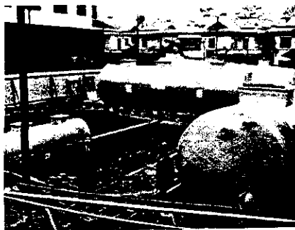
Hình 7.36. Bể xử lý nước thải hợp khối AFSB
