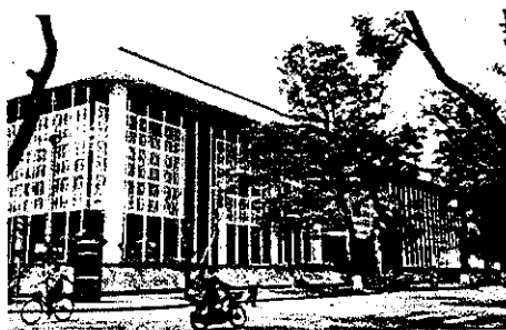
Hình 5.44. Ví dụ công trình sử dụng tường hai lớp bao phủ toàn bộ mặt đứng công trình: a) kính + lam chớp hợp kim; b) kính + vải dây căng (Thư viện quốc gia King Fahad, Riad/ Ả rập Xê út); c) kính + tấm hoa trang trí (Trung tâm Hội nghị quốc tế, Hà Nội).
