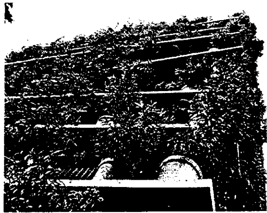
Hình 9.7. Cây xanh bao phủ hành lang công trình
